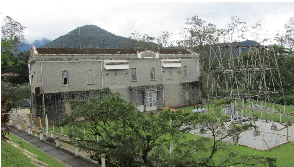
Figura 5 – Casa de força, 2013. Fotografia da autora.
