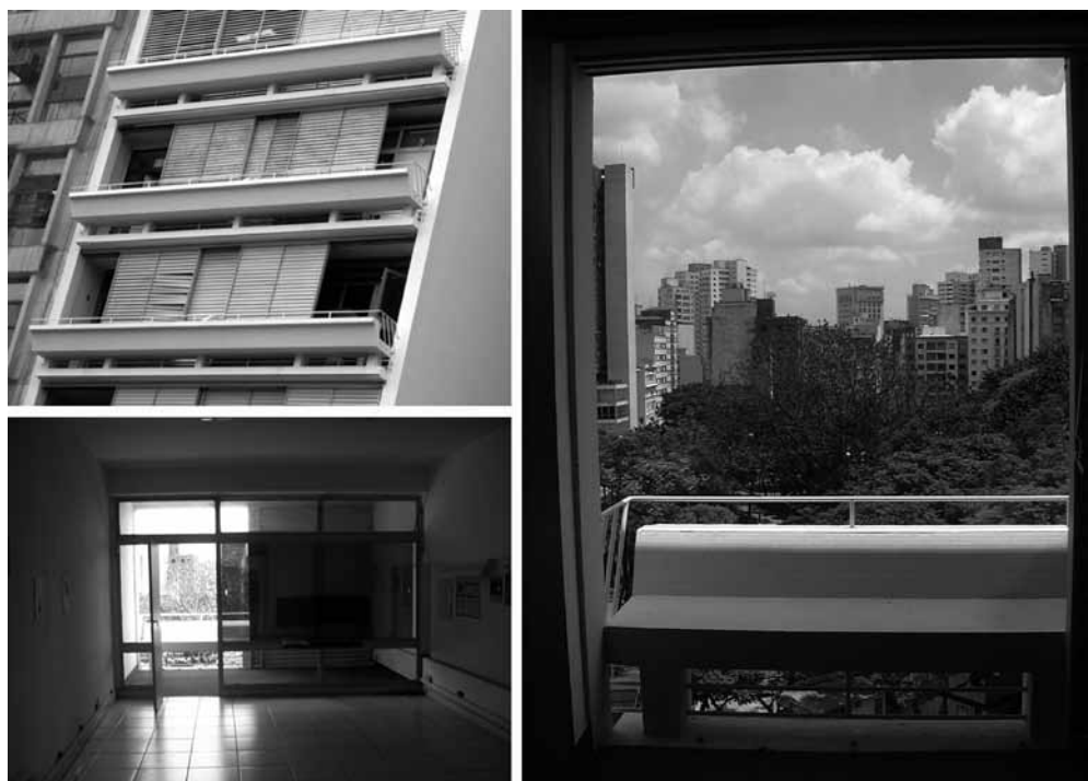
Figura 3 – Adolf Franz Heep. Edifício Atlanta (construído entre 1945 e 1949), São Paulo. Fonte: Fotografias da autora.
