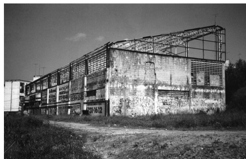
Figura 1. Galpão abandonado: ponto de drogas.
