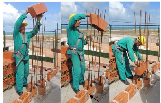
Figura 13. Assentamento de blocos.
