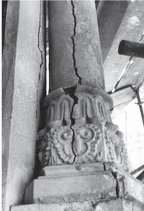
Figura 3: Trinca nos elementos de argamassa armada da torre sul, c.1990 (Acervo DPH/COC)
