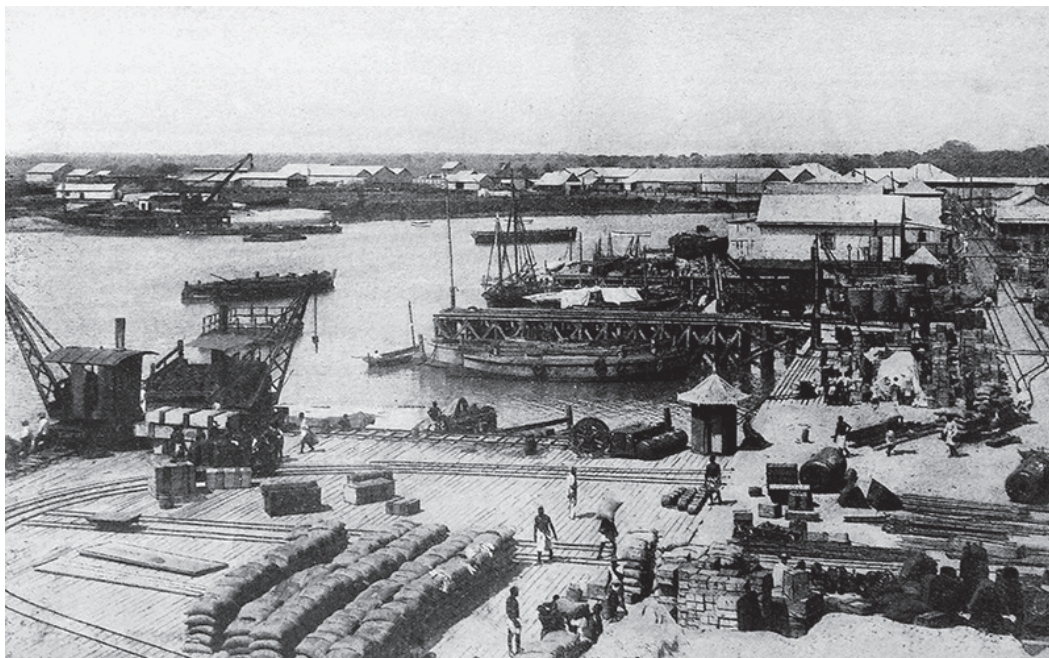
Figura 4: Panorâmica do porto da Beira, incluindo cais, linhas de acesso e diversos trabalhadores; legenda original: "O porto em 1904" (Fonte: Quarenta..., 1934)
