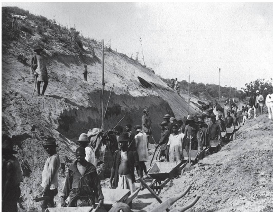
Figura 14: Trabalhadores nativos abrindo uma trincheira para a linha de Lourenço Marques (Fonte: Views..., c.1887)
