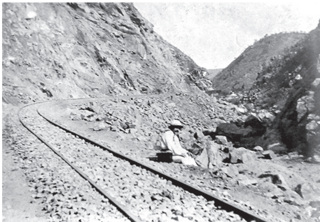
Figura 7: Engenheiro sentado na linha de Benguela à passagem em Lengue; legenda original: "Finished line in Lengue, viaduct no. 1 in distance. June 1906" (Fonte: Benguela Railway, c.1906)
