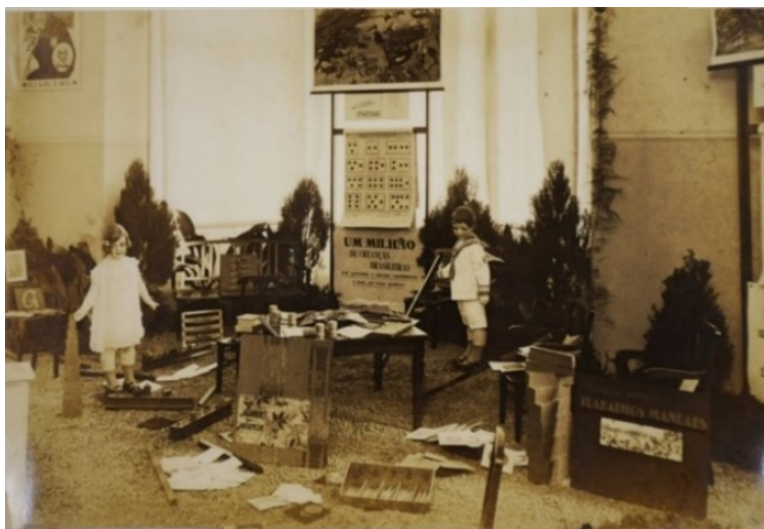
Figura 3 – Outro aspecto da Exposição de material escolar da Companhia Melhoramentos de São Paulo, na rua Líbero Badaró, em 1929.
