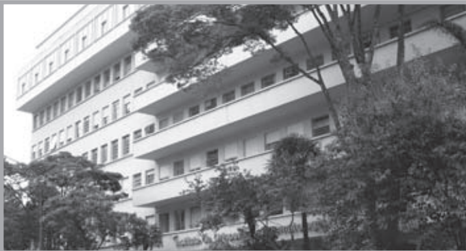
Fachada do Instituto de Ortopedia e Traumatologia do Hospital das Clínicas da Universidade de São Paulo.
