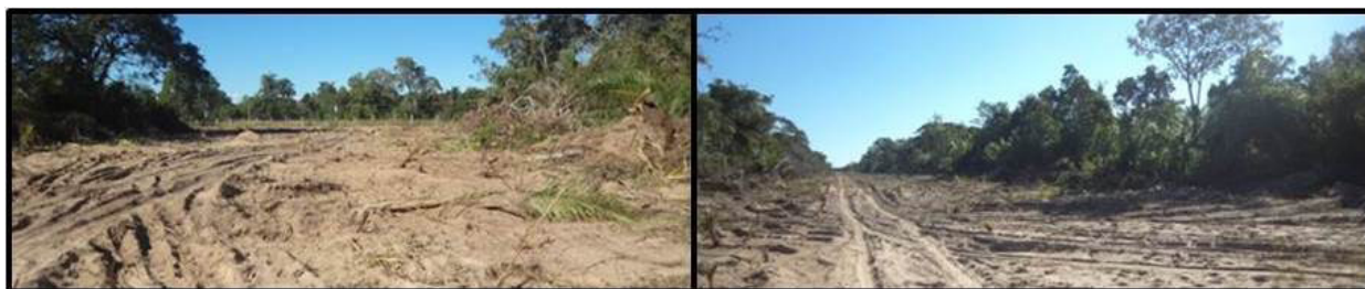
Figura 9 - Área desmatada para instalação da rede de energia no Pantanal da Nhecolândia (Fotos: M. Silva – 2012)
