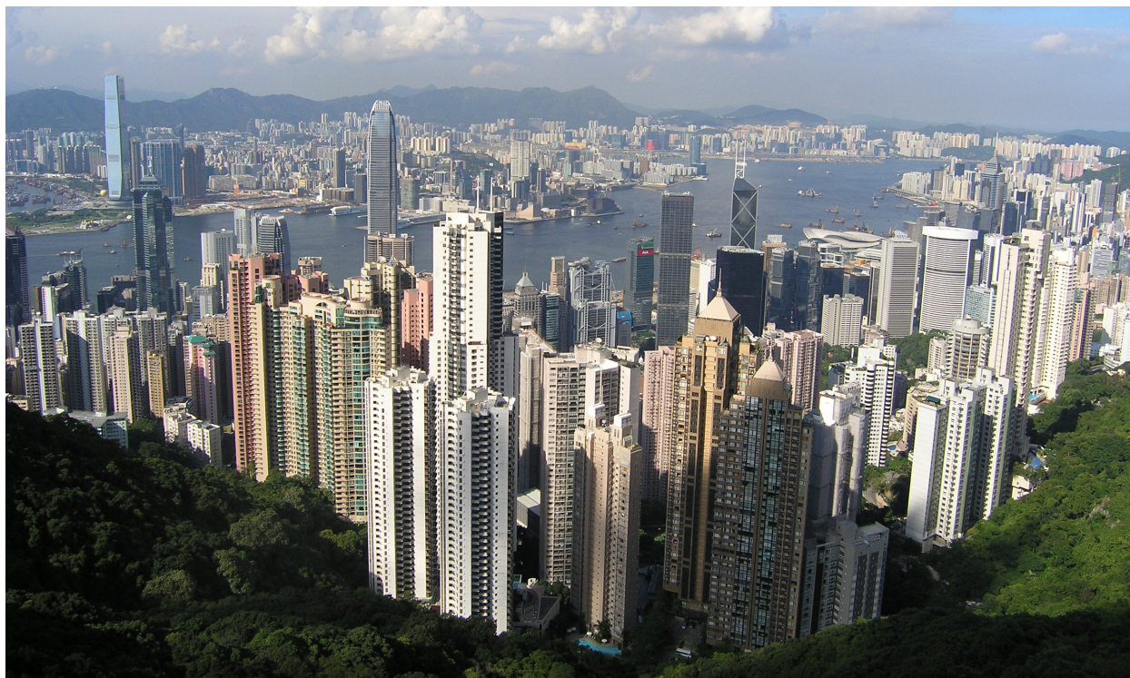
Figura 4 - Vista do alto do Monte Victória (Ilha de Hong Kong). Muitos edifícios típicos de locação social pública em Hong Kong são “genéricos” e localizam-se nas áreas mais centrais, tanto na ilha quanto na porção continental. Os mais recentes localizam-se nos “Novos Territórios”, além das montanhas que se veem ao fundo. Em geral, são grandes conjuntos com vários edifícios altos, conectados ao Centro da cidade por metrô, trem ou ônibus.
