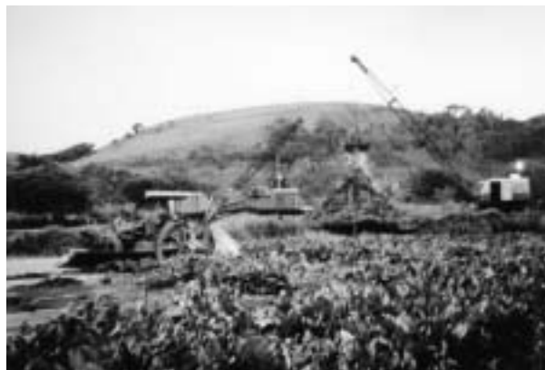
Figura 3 - Guindaste fixo na margem para retirada das plantas do reservatório.
