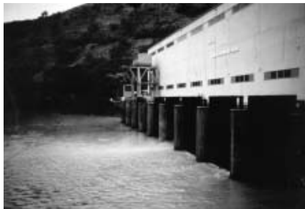
Figura 4 - Sistema de limpeza das grades da tomada d'água da usina de bombeamento.
