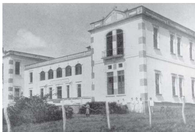
Figura 3. Prédio onde funcionou o Curso Superior de Agricultura “São Bento” em Tapera, atualmente inundado pelas águas da Represa do Rio Tapacurá. Foto retirada do álbum das “Escolas Superiores de Agricultura e Medicina Veterinária - 1913-1923. Friburgo/Alemanha: Tipographia Herder & Cia, 1923
