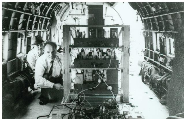
**Figura 11:** Gleb Wataghin e pessoa não identificada junto a aparelho para medidas de raios cósmicos dentro de avião da FAB para experiência em grandes altitudes. [1940]. Foto do acervo IFUSP.
