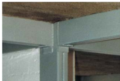
Figura 2 - Vigas e pilares.
