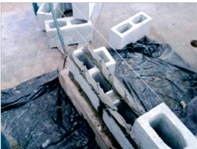
Figura 13 Ilustração das paredes com assentamento parcial (argamassa somente nas as paredes longitudinais dos blocos)
