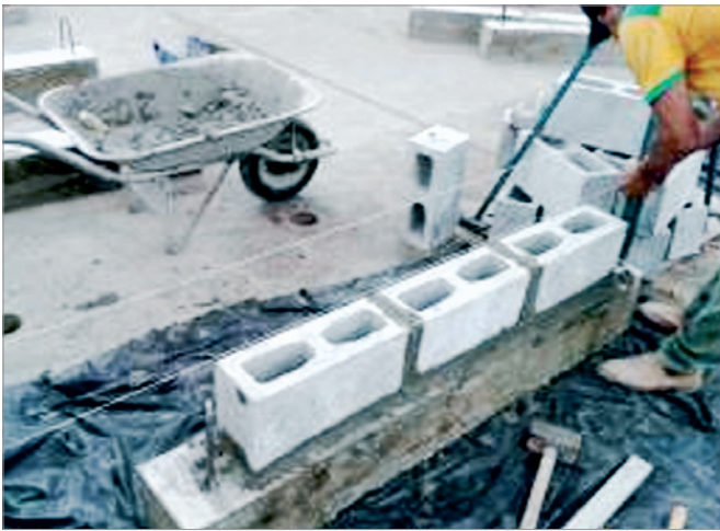
Figura 7 Escantilhões para auxiliar na construção das paredes
