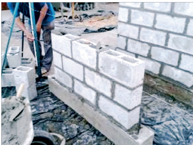
Figura 9 Ilustração das paredes ocas (sem grauteamento)
