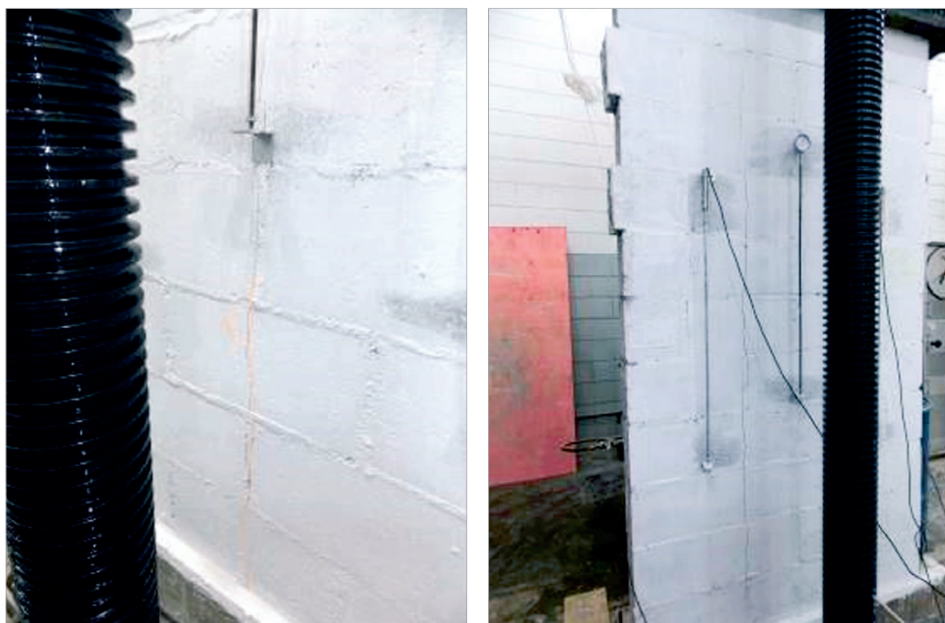
Figura 31 Modo de ruptura das paredes grauteadas
