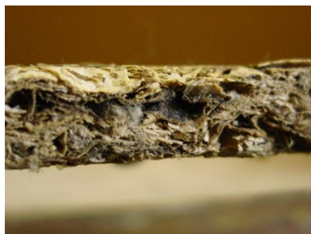
Sem tratamento preservante (T1-M)
