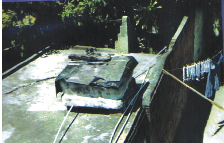
Figura 5 - Caixa d'água localizada sobre a laje.
