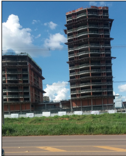
Figura 4 - Obras do Via Towers. Fonte: Janete Farias, arquivo pessoal, julho de 2017.
