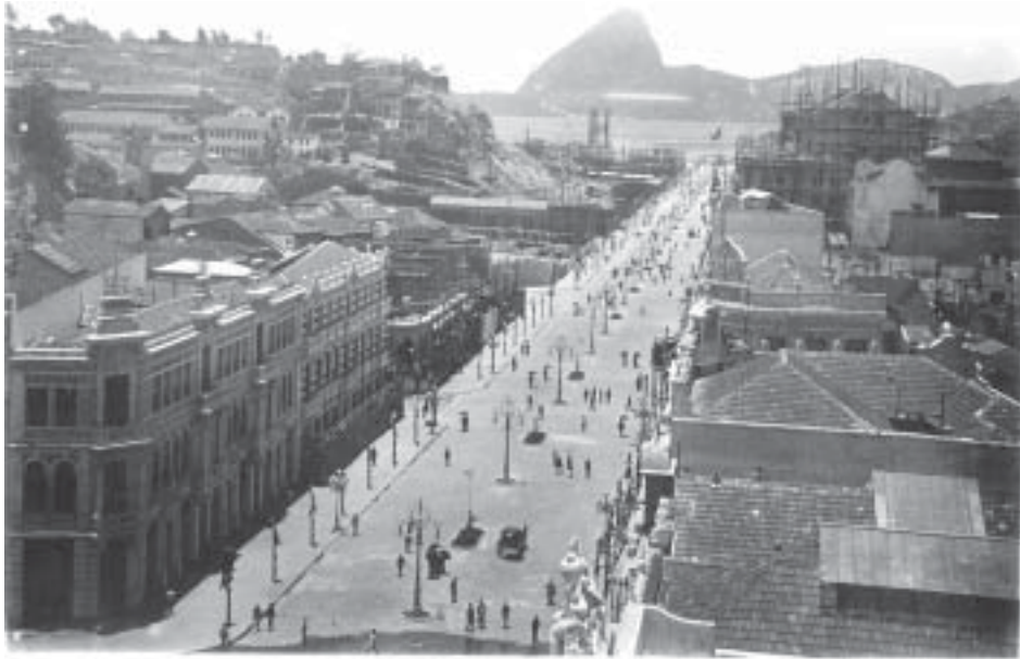
A Avenida Central, em direção às obras da orla, na Praia de Santa Luzia, tomada de um edifício nas proximidades da Rua da Assembléia. A construção da Escola Nacional de Belas Artes e da Biblioteca Nacional, à esquerda, aos pés do Morro do Castelo, estava em fase inicial. À direita, a construção do Teatro Municipal, em fase mais adiantada. Fotografia de João Martins Torres, 1905-1906 - Coleção Álvaro de Frontin Werneck
