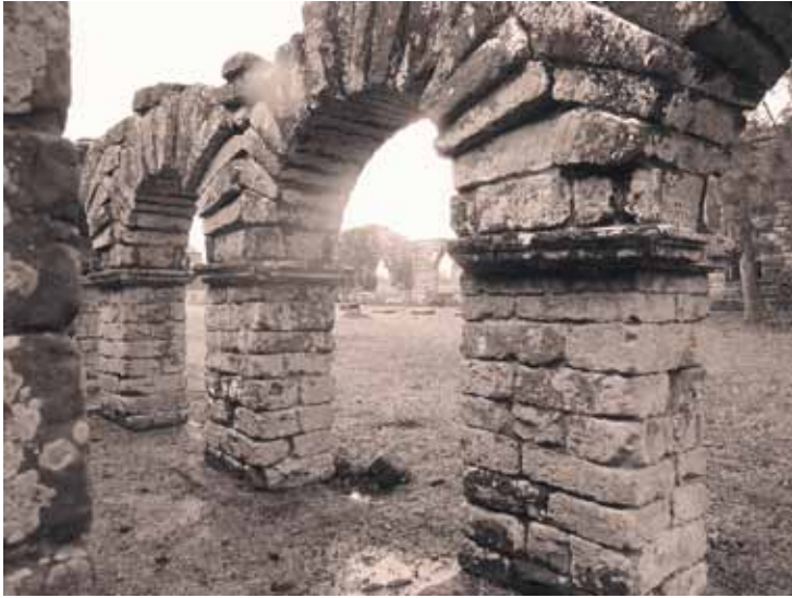
Figura 4. Arcos de meio ponto.
