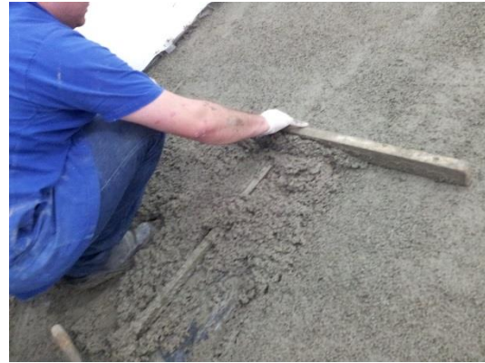
Figura 4 - Instalação do contrapiso na câmara com a base de lona plástica e o gabarito para o controle da espessura
