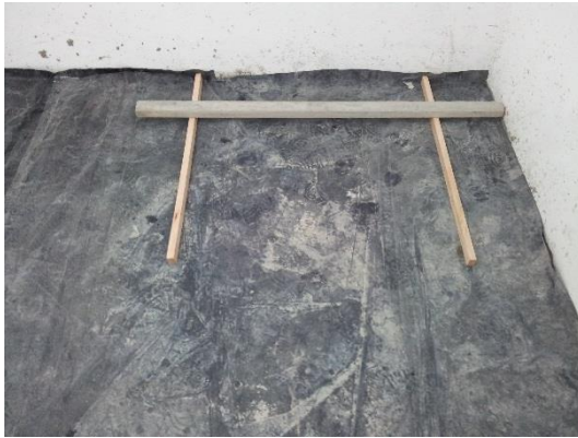
Figura 4 - Instalação do contrapiso na câmara com a base de lona plástica e o gabarito para o controle da espessura
